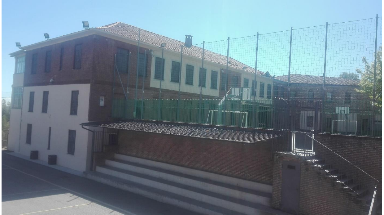
Foto 2: vista dell'oratorio esistente
