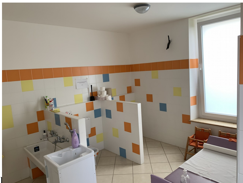
WC BAMBINI CON FASCIATOIO
