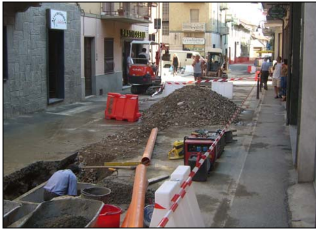
Lavori di riqualificazione del Centro Storico: via Gramsci.
