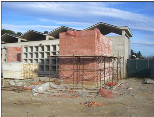
Lavori per l'ampliamento del cimitero
