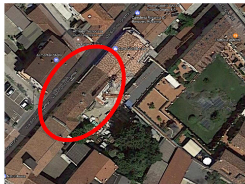
Immagine zenitale del fabbricato
