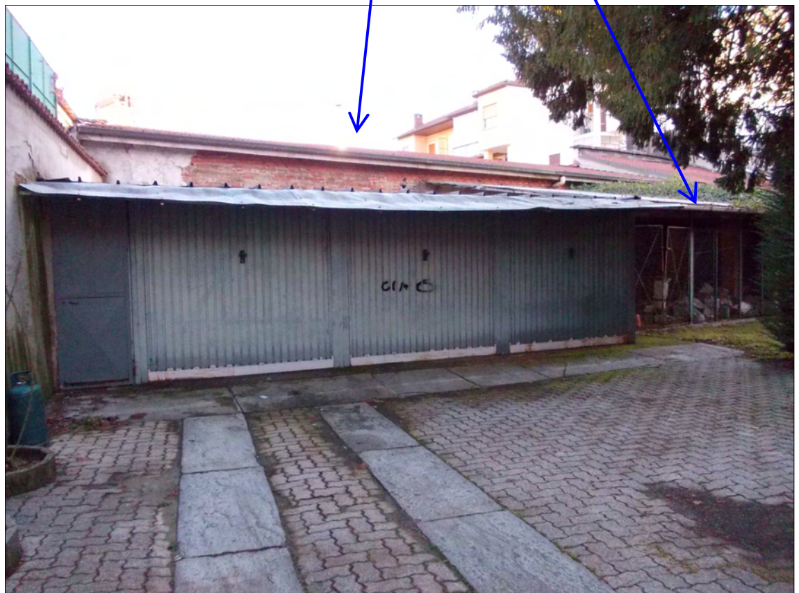
Unità 8B, fabbricati 5 e 6
