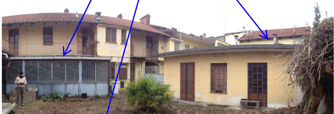
Unità 10B, fabbricati 5 e 6
