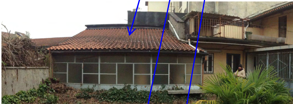
Unità 11B, fabbricati 2 e 3
