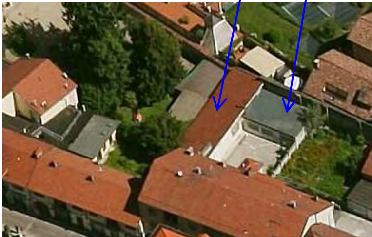
Unità 11B, fabbricati 3 e 4
