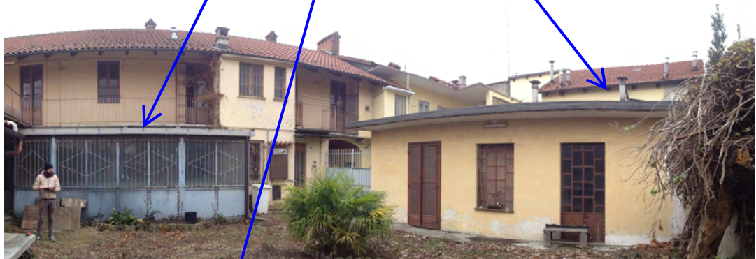
Unità 10B, fabbricati 5 e 6
