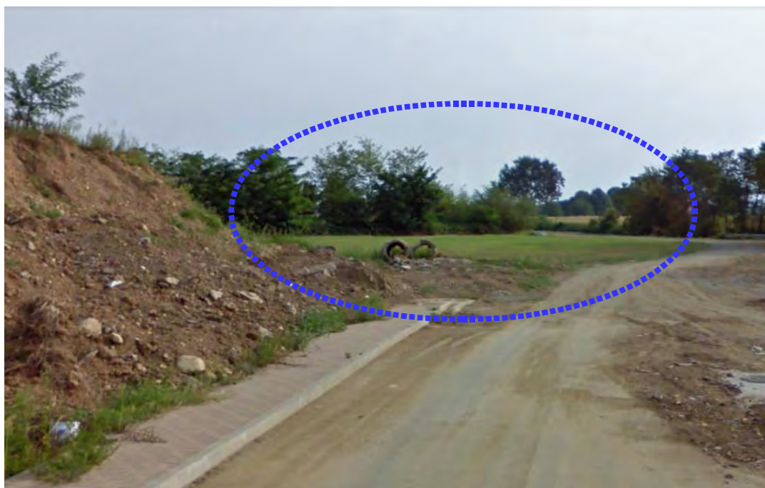
Area Via Pasturanti/Via san Bernardo
