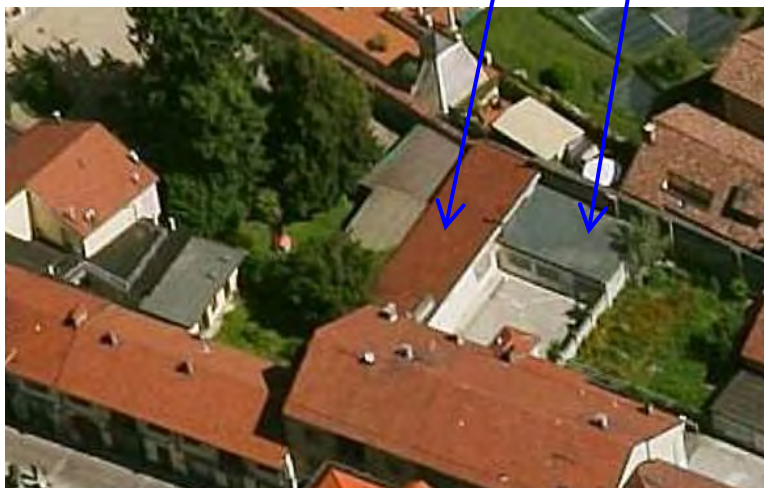
Unità 11B, fabbricati 3 e 4
