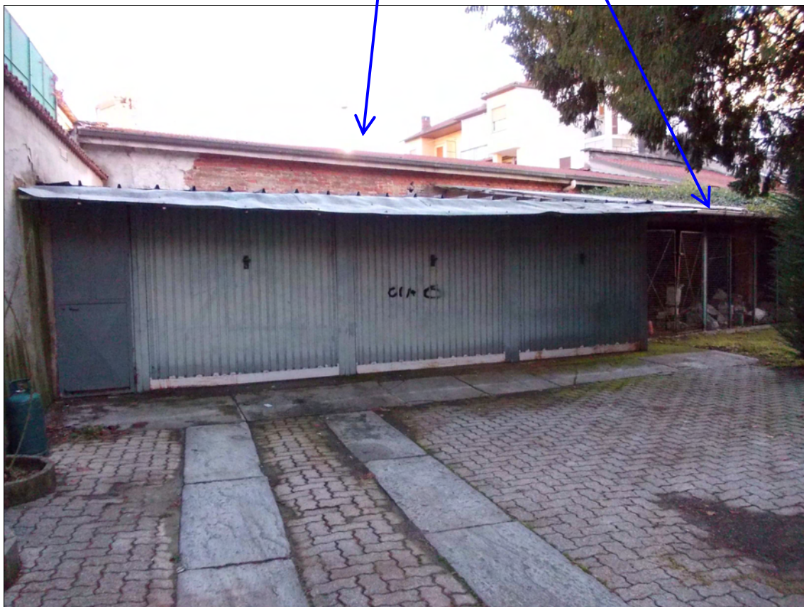
Unità 8B, fabbricati 5 e 6
