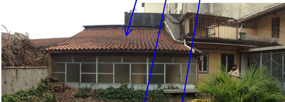
Unità 11B, fabbricati 2 e 3
