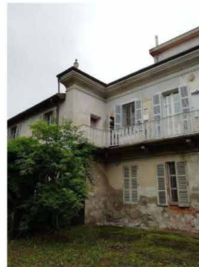
Facciata cortile interno verso corpo principale della Villa
